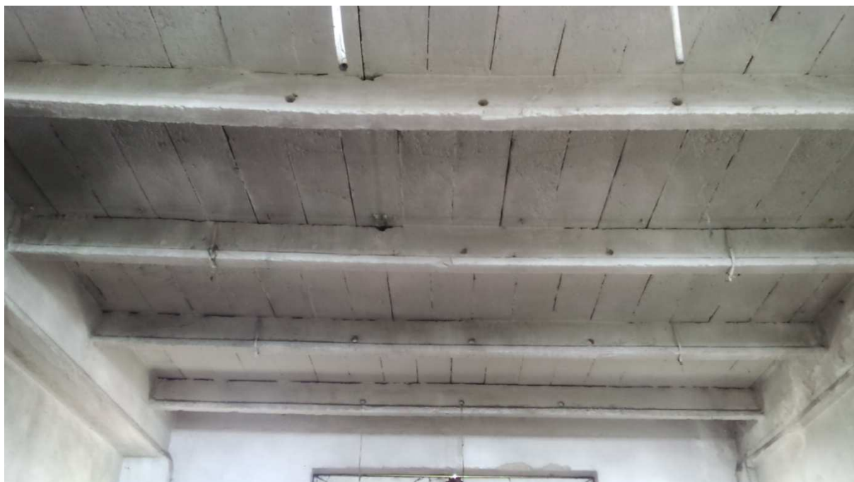
Fot. 31 Widoczne betonowe belki dachu garażu wraz z płytkami korytkowymi
