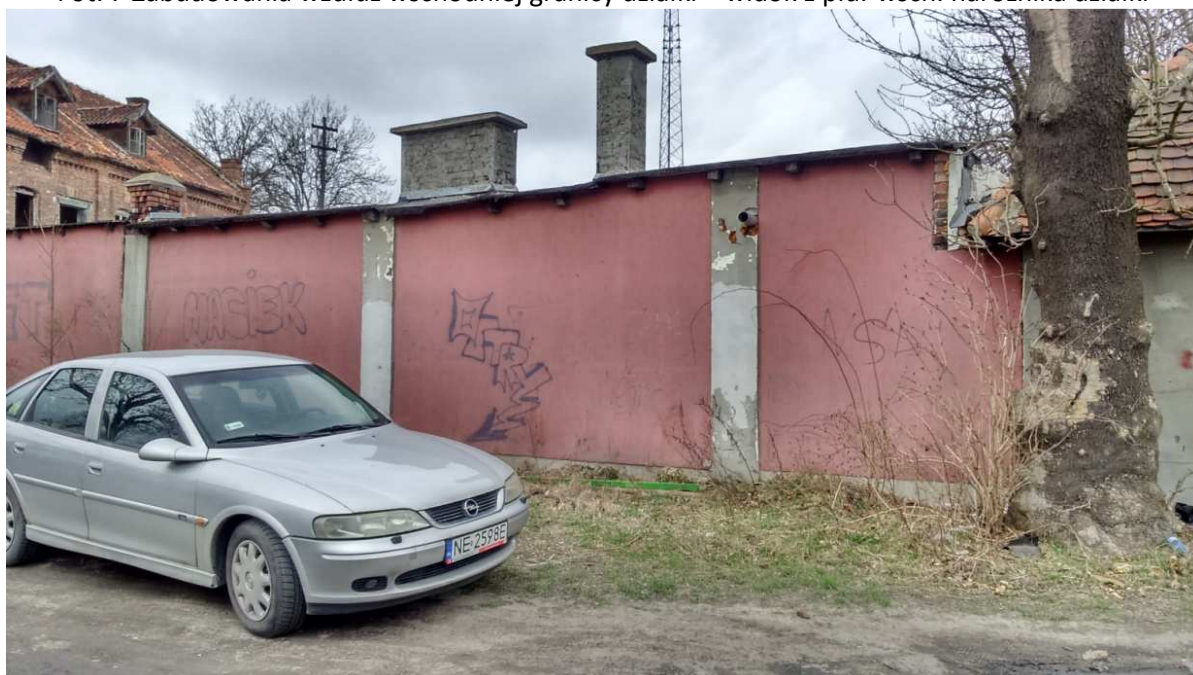
Fot. 8 Zabudowania wzdłuż wschodniej granicy działki – widok od ul. Kotwiczaj (od południa)
