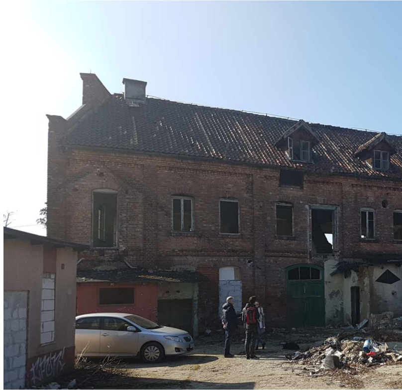
Fot. 2 Budynki we wschodnim skrzydle
