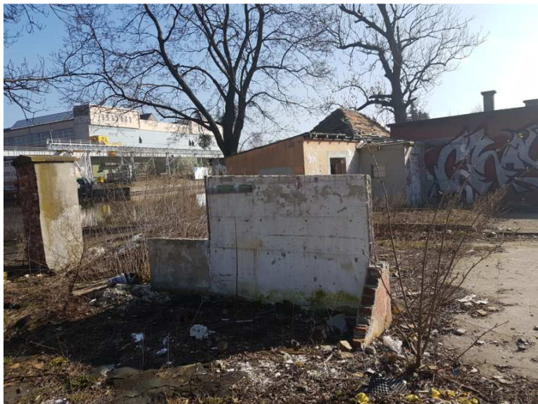
Fot. 36 Obiekt V – widok od podwórza (od północy)
