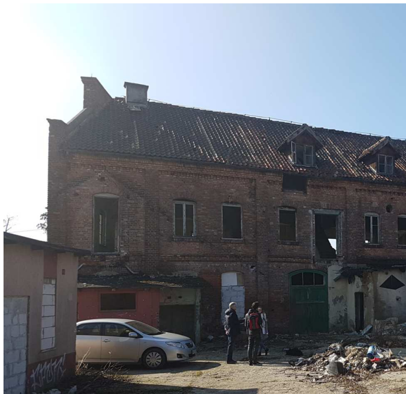
Fot. 2 Budynki we wschodnim skrzydle
