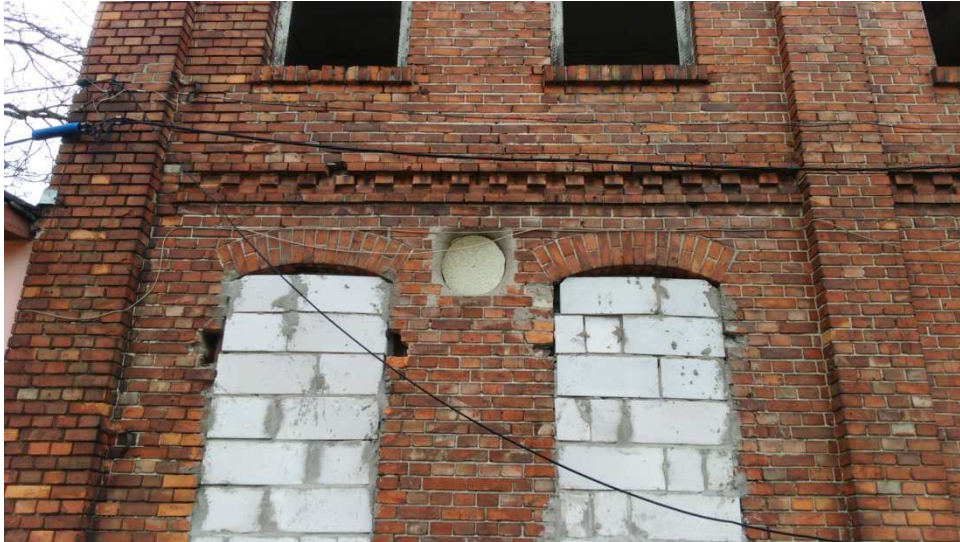
Fot. 21 Prowizorycznie zamurowane otwory okienne
