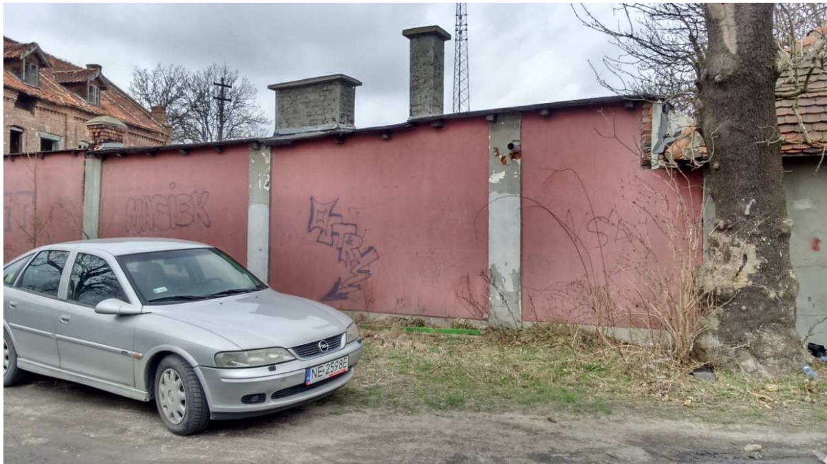
Fot. 9 Substandardowa dobudówka do budynku usługowego
