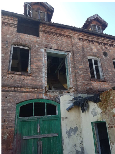
Fot. 20 Otwór w murze po rozebranych schodach
