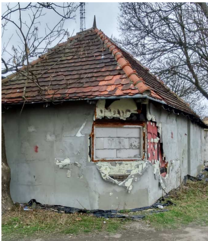
Fot. 7 Zabudowania wzdłuż wschodniej granicy działki – widok z pld.-wsch. narożnika działki
