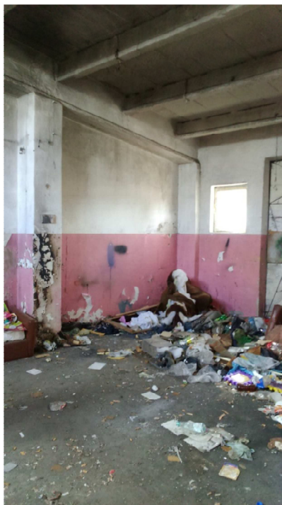
Fot. 30 Wnętrze garażu ukazujące część konstrukcji dachu
